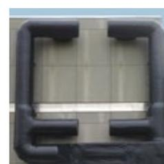
Beim Verbinden der Stücke ist eine Überlappung von nur 20 mm ausreichend, um die isolierten Leitungen absolut wasserdicht zu verkleiden. WrapTec kann bis zu 50% in alle Richtungen gedehnt werden.
